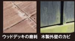
ウッドデッキの磨耗 木製外壁のカビ
